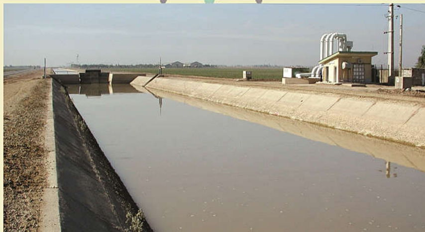
ایستگاه پمپاژ و کانال اصلی مجتمع نیشکر امیرکبیر
