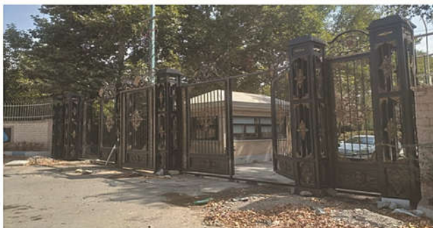
نصب درب اصلی خیابان آب و خاک
