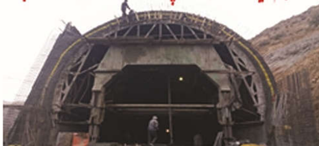
انجام عملیات بتن ریزی بتن پارت ۱۰ اکلاری خروجی تونل ۳۱ غربی
