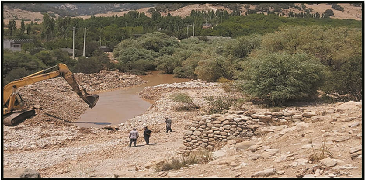
استان کهگیلویه و بویراحمد منطقه طسوج - اصلاح سرشاخه پاکسازی و لایروبی مسیر انتقال آب باغات
