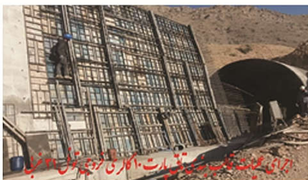
انجام عملیات بتن ریزی بتن پارت ۱۰ اکلاری خروجی تونل ۳۱ غربی
